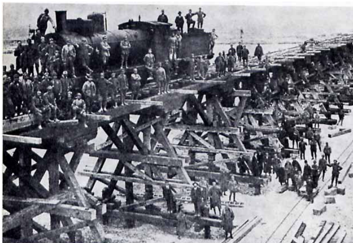
Ponte provvisorio in legno sul Piave tra Fagarè e Ponte di Piave
