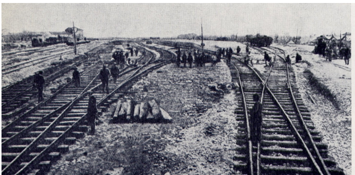
Ampliamento di stazioni in zona di guerra A cura delle Compagnie Ferroviarie
